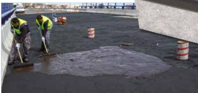
Foto 2: aplicación de Proamastic Fibra
